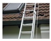
Anlege-, Schiebe- und Mehrzweckleitern sind zum Übersteigen geeignet, wenn sie mindestens einen Meter überstehen oder bauseits Festhaltemöglichkeiten vorhanden sind. Um das Verrutschen zu vermeiden, sollten Einhakvorrichtungen verwendet werden.
